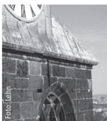
Auch die Turmhaube muss im Zuge der Sanierung erneuert werden.
